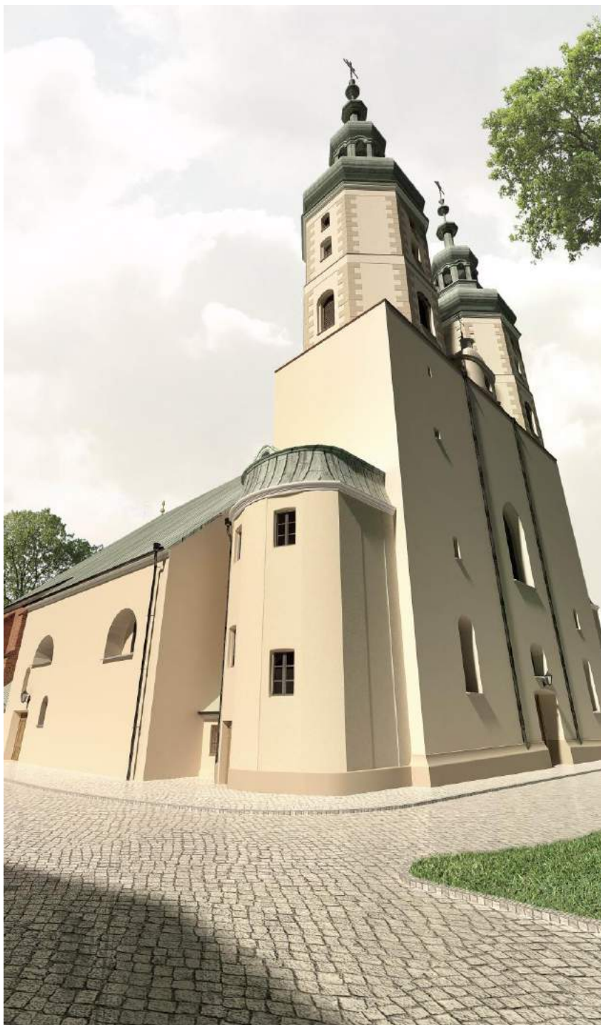
TEMAT OPISACOWYWA: RENOWACJA ELEWACJI KOŚCIOŁA PARAFIALNEGO PW. ŚW. BARTŁOJEMIA APOSTOŁA
